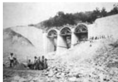
Un cantiere della nuova ferrovia Parma - La Spezia a Guinadi.
